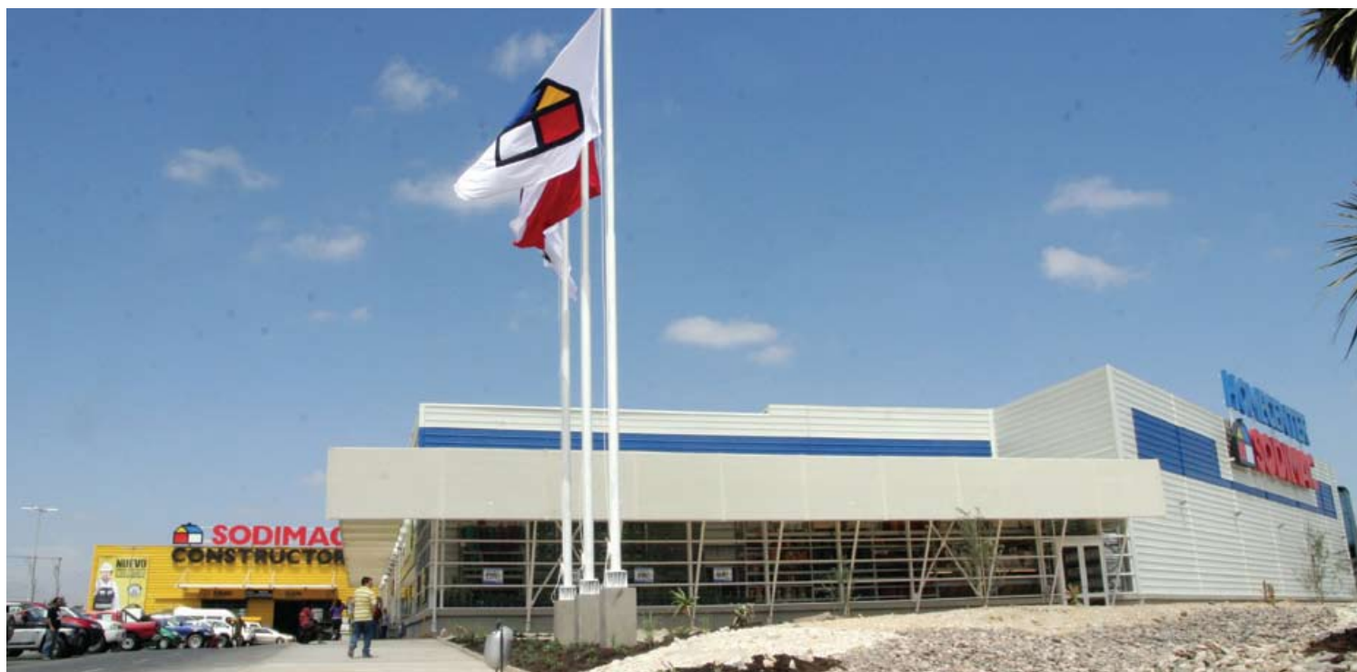
CERTIFICACIÓN LEED A HOMECENTER SODIMAC COPIAPÓ / SODIMAC
