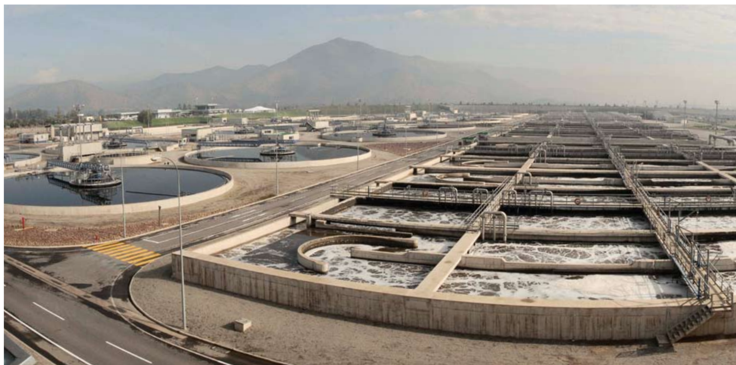
BIOGÁS / METROGAS S.A., GESTIÓN Y SERVICIOS S.A., AGUAS ANDINAS
