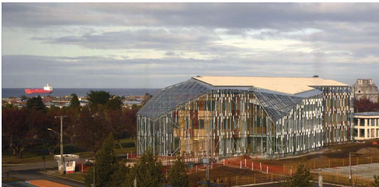
EDIFICIO BIOCLIMÁTICO DE ENAP PUNTA ARENAS / GROSS ARQUITECTOS Y ALBERTO CONTESSE
