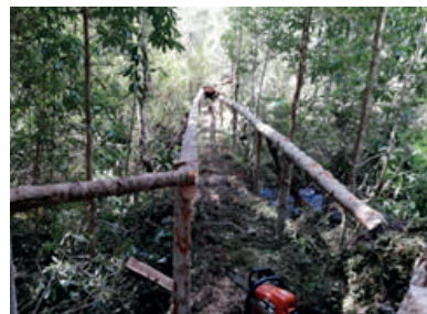
Mejoramiento sendero en BNP Laguna Caiquenes. Imagen: ONG Aumen
